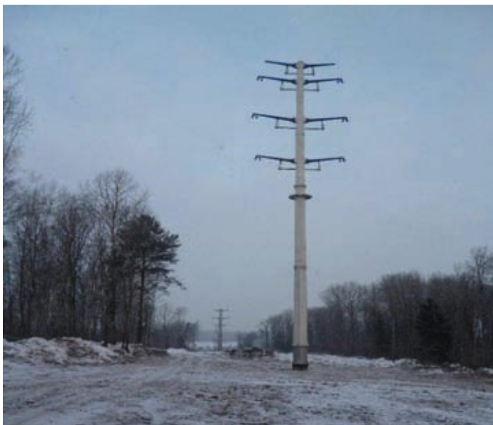
ПОВЫШЕННАЯ ПРОМЕЖУТОЧНАЯ МНОГОГРАННАЯ ОПОРА ВЛ 220 КВ ПМ220-2В-18. НА ФОТО: СОКРАЩЕНИЕ ТРЕБУЕМОЙ ШИРИНЫ ПРОСЕКИ С 25 МЕТРОВ ОТ КРАЙНЕГО ПРОВОДА ДО 2-Х МЕТРОВ
