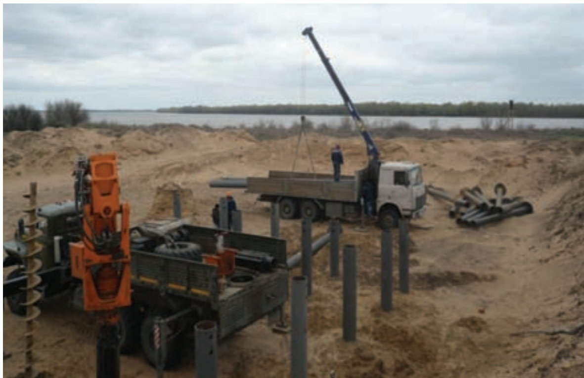
УСТРОЙСТВО ЛИДЕРНЫХ СКВАЖИН И ПОГРУЖЕНИЕ ВИНТОВЫХ СВАЙ МАНИПУЛЯТОРОМ
