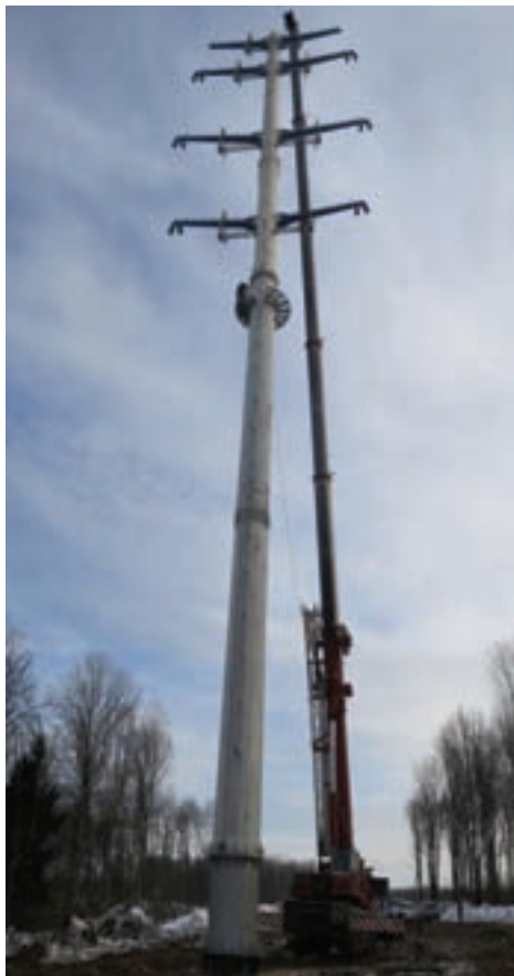
ПОВЫШЕННАЯ ПРОМЕЖУТОЧНАЯ МНОГОГРАННАЯ ОПОРА ВЛ 220 КВ ПМ220-2В-18. НА ФОТО: СОКРАЩЕНИЕ ТРЕБУЕМОЙ ШИРИНЫ ПРОСЕКИ С 25 МЕТРОВ ОТ КРАЙНЕГО ПРОВОДА ДО 2-Х МЕТРОВ
