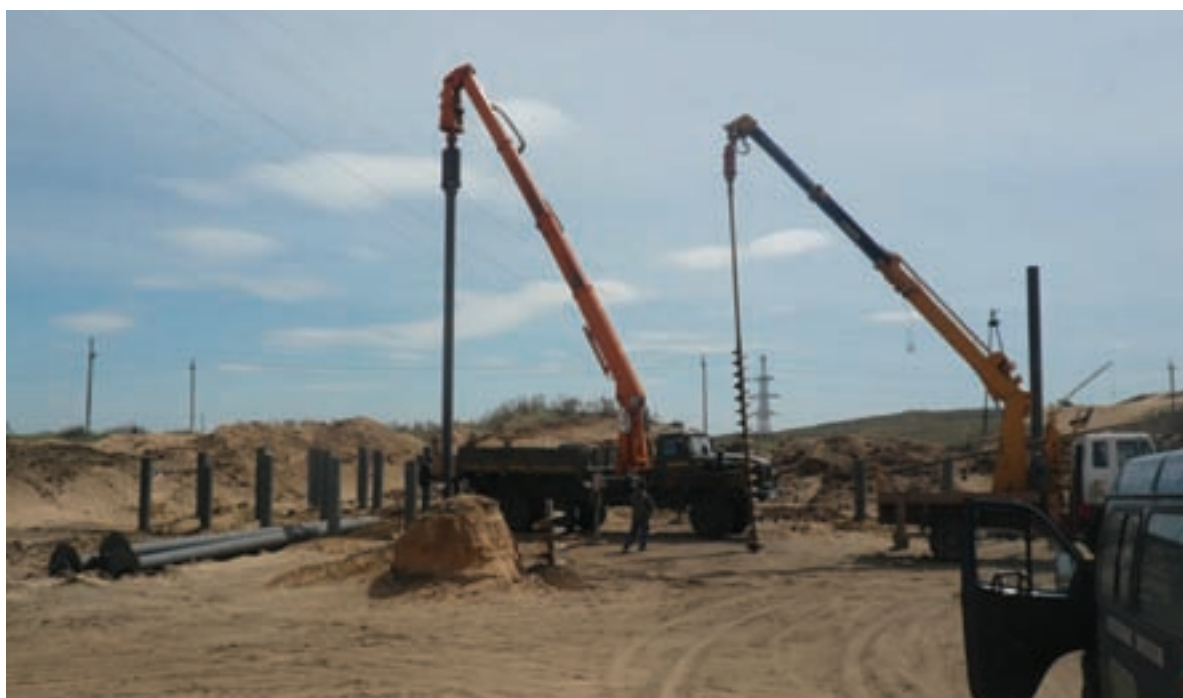
УСТРОЙСТВО ЛИДЕРНЫХ СКВАЖИН И ПОГРУЖЕНИЕ ВИНТОВЫХ СВАЙ МАНИПУЛЯТОРОМ
