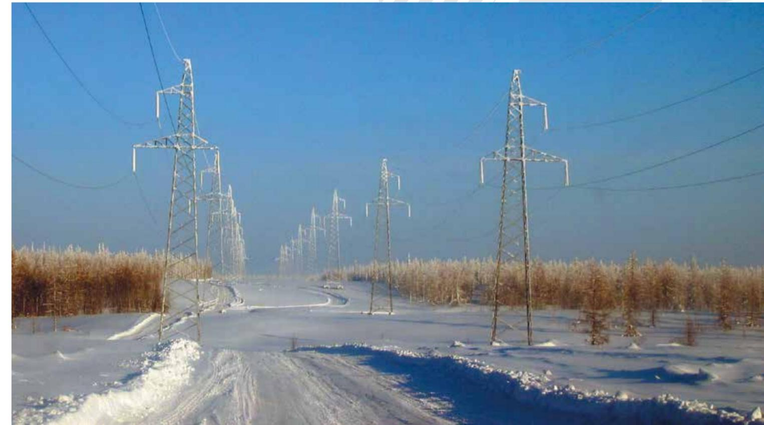
паводки каждые 8-12 лет их размывают, поэтому фундаменты для переходных опор (высота опор 96 м) сделали мостового типа, на железобетонных монолитных ростверках весом более 300 тонн, закрепленных на буронабивных сваях.
